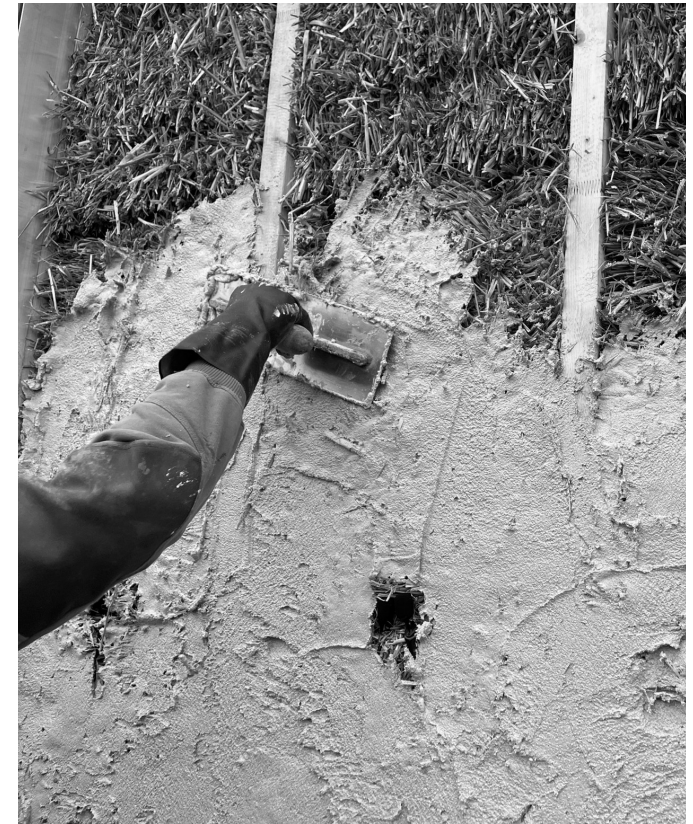
Pleisteren van een strobalenwand
