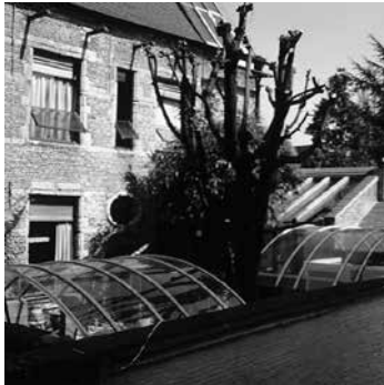
Verbouwing begijnhofwoning Rénovation d'une maison du béguinage Renovation beguinage house
