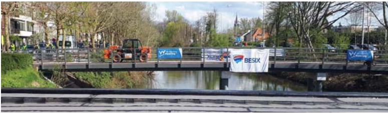
Canadabrug, Brugge (dienstvoertuig, in situ)
