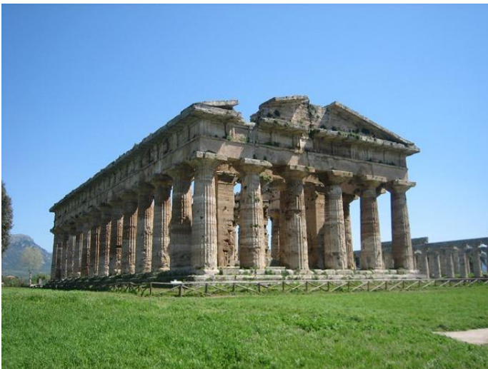
Figuur 8 De Griekse tempels in Zuid-Italië, zoals deze Archaïsche Dorische tempel in Paestum , oefenden grote invloed uit op de Romeinse architectuur
