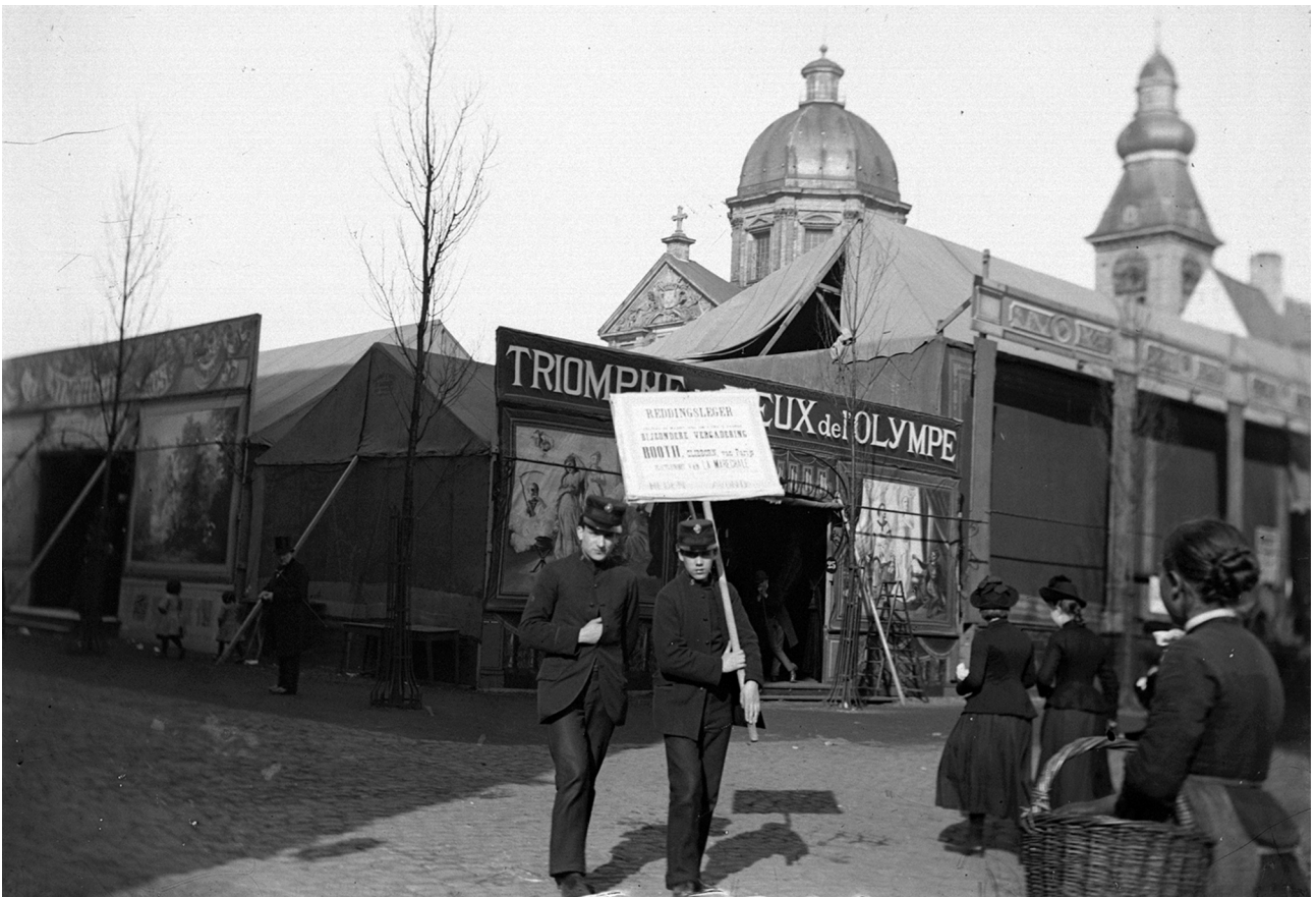
ILLUSTRATIE 1: Een foorbarak op het Sint-Pietersplein met opschrift 'Triomphe [des] Jeux de l'Olympe.' Waarschijnlijk is dit een kleine bioscoop. Naast de ingang hangt een bordje met als opschrift '25', wat duidt op de entreprijs. De structuur van deze foorbarak is goed te zien: een tent van zeildoek over een houten gebinte, een versierde façade en stutbalken. Bron: Huis van Alijn, Gent, Collectie A. Vander Haeghen, 1890-1896
